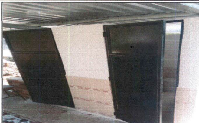
Foto 2: MEJORAMIENTO DE SERVICIOS SANITARIOS Y SUS ACCESORIOS.
